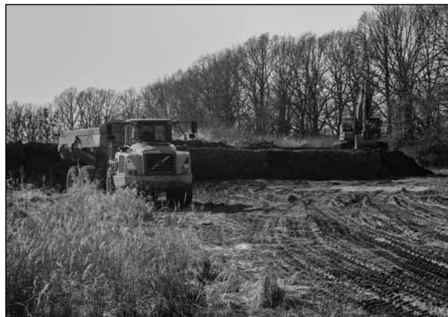
Převoz zeminy pro úpravu hrází z mezidoponie do rybníční pánve.
