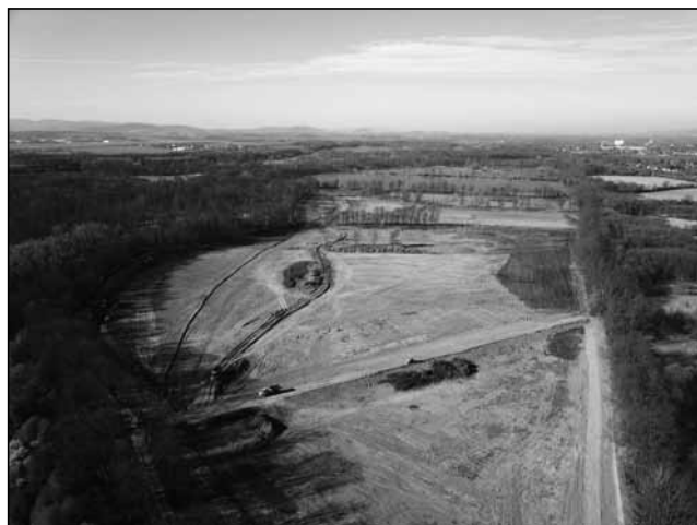
Letecký pohled na lokalitu PR Bažantula v době provádění stavebních prací (Foto Zbyněk Sovík).
