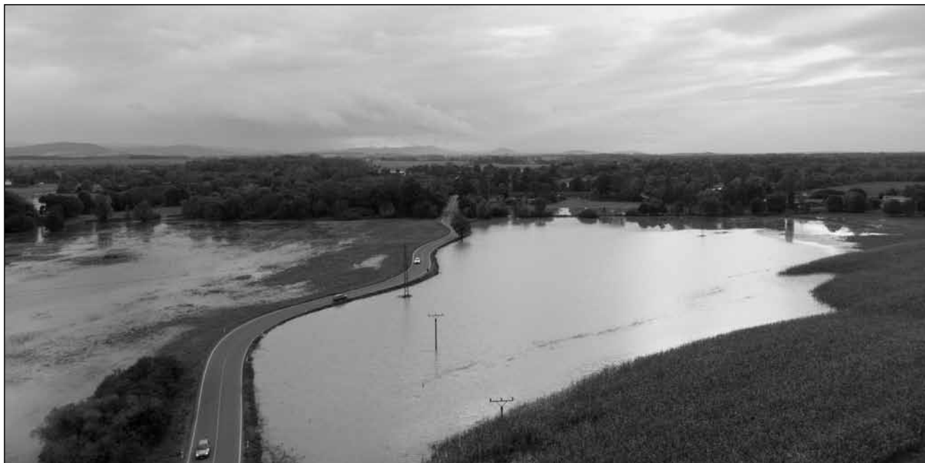
Celkový pohled na lokalitu – vpravo od silnice vedoucí od nádraží ve Studénce směrem na Novou Horku (Foto Zbyněk Sovík).
