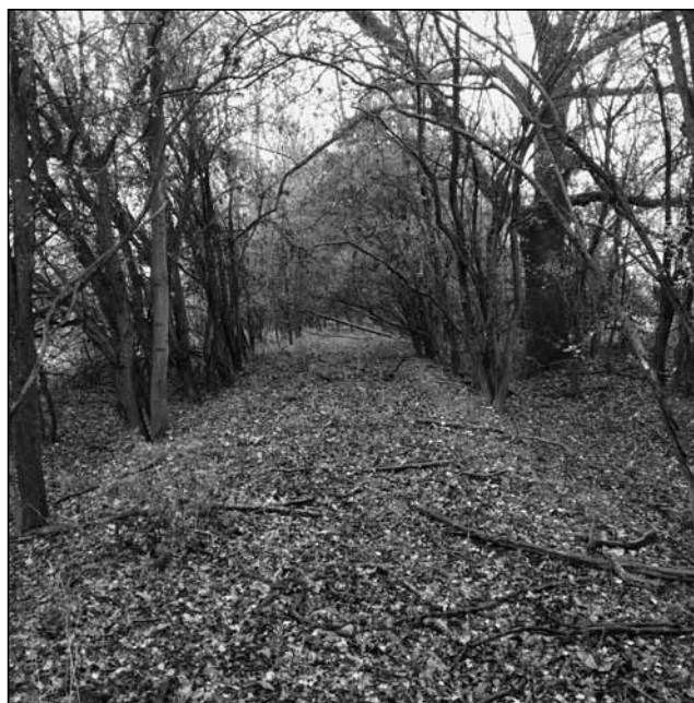
Stále ještě dobře patrné těleso cesty šířky 4,5 až 5,0 m se dvěma příkopy po stranách.
