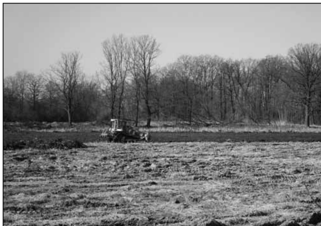
Výhrnování sedimentu buldozorem ze zátopy Velkého Okluku.
