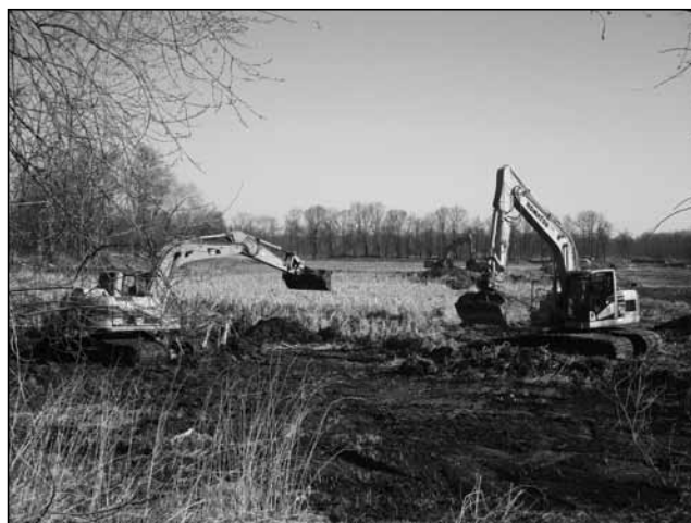
Terénní úpravy dna rybníka Velký Okluk pásovými bagry.
